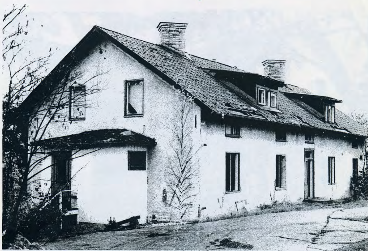
Långfasad mot söder, gavelfasad mot väster.
