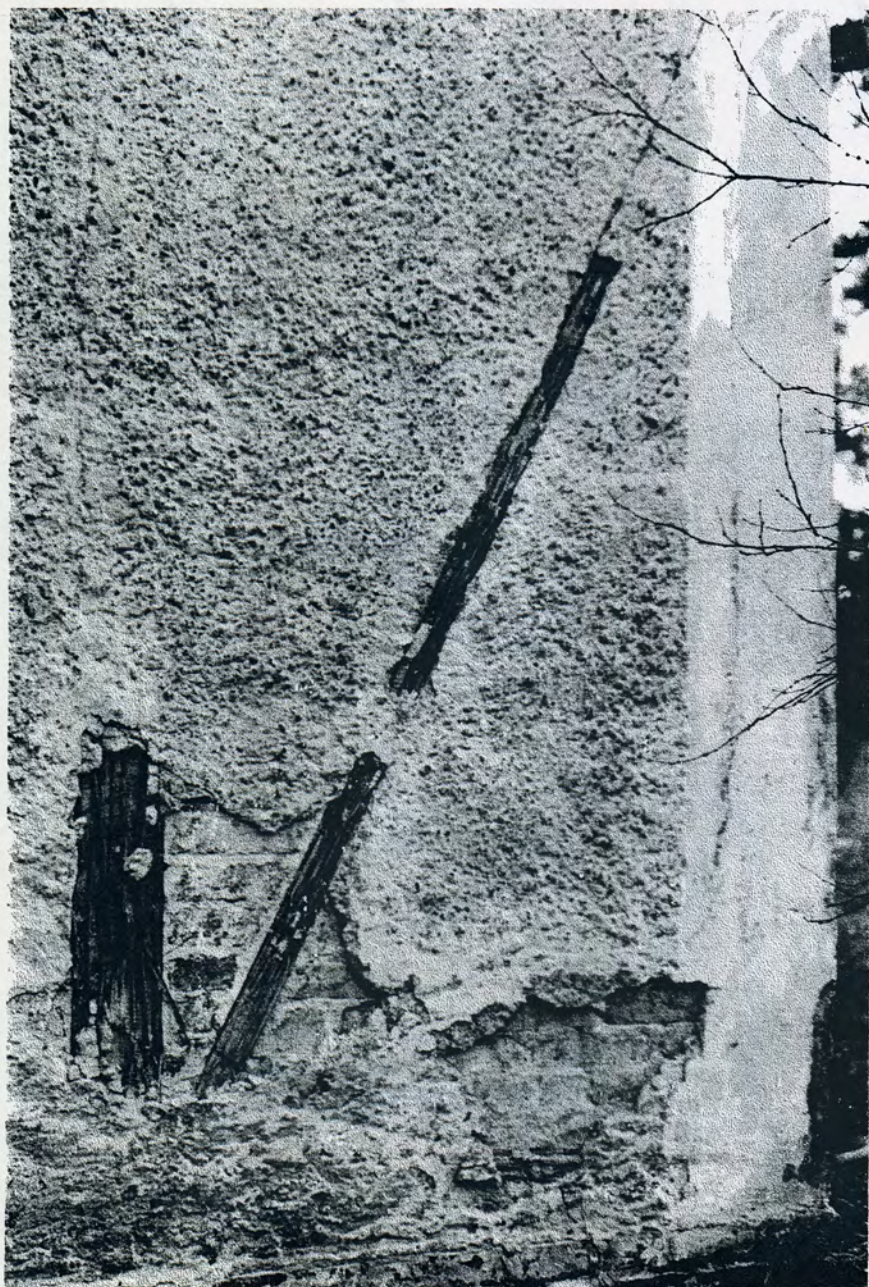
Fasad (korsvirke, tegelfyllnad och puts)
