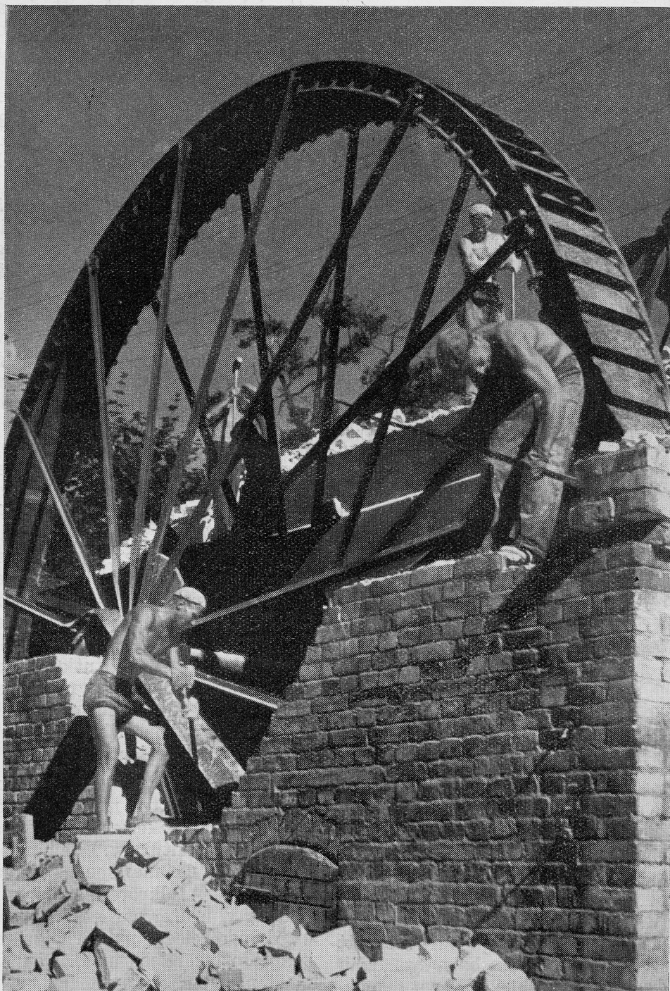
Det gamla vattenhjulet. Se art. å sid. 15.
