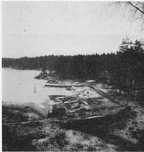
Extra pumpanordning vid den låga Kvarnsjön.
