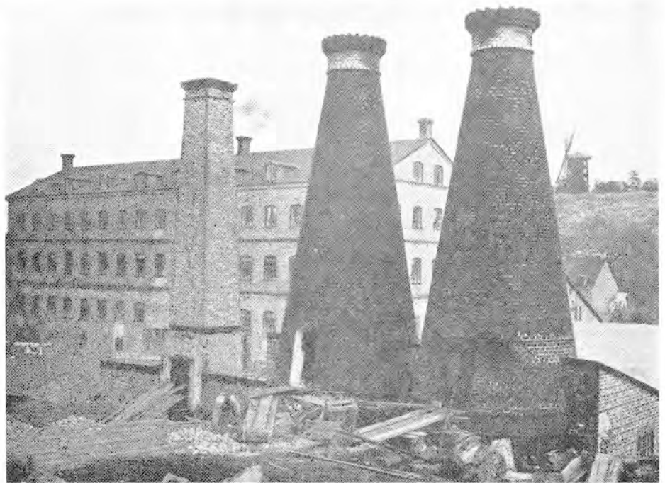
Exteriör af flintugnen och stora maskinhuset.
