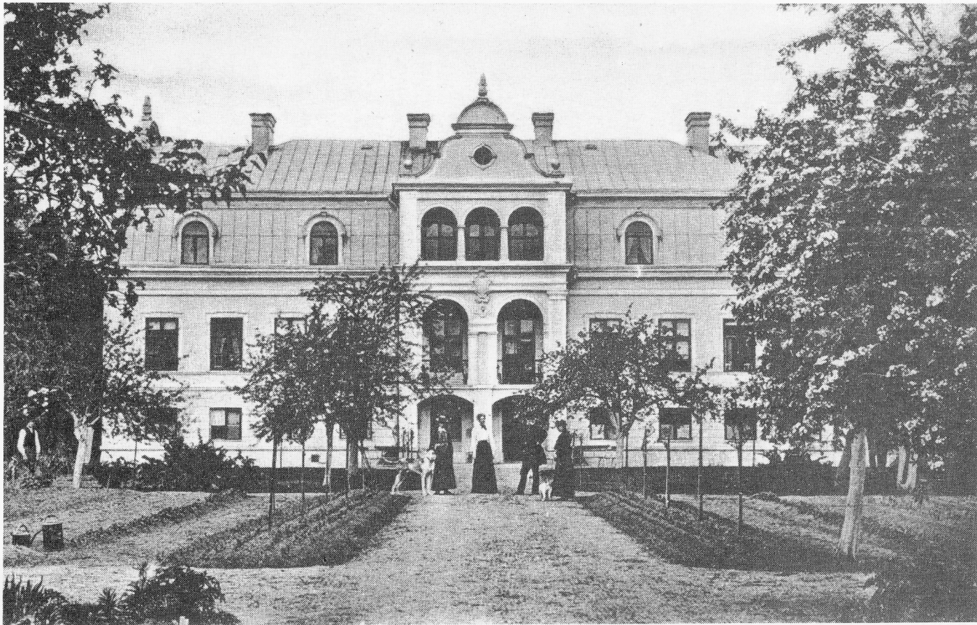
Farsta efter 1890-talets besynnerliga ombyggnad. Foto: George Barlow.
