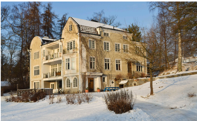
Villans östra och södra sida idag.
