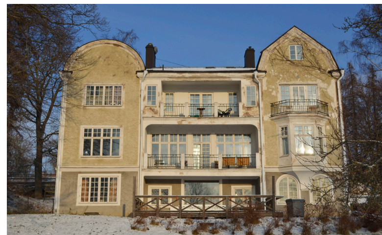
Villans södra fasad med sina stora balkonger med ursprungligt smide och ursprungliga fönster- och fönsterdörrar.
