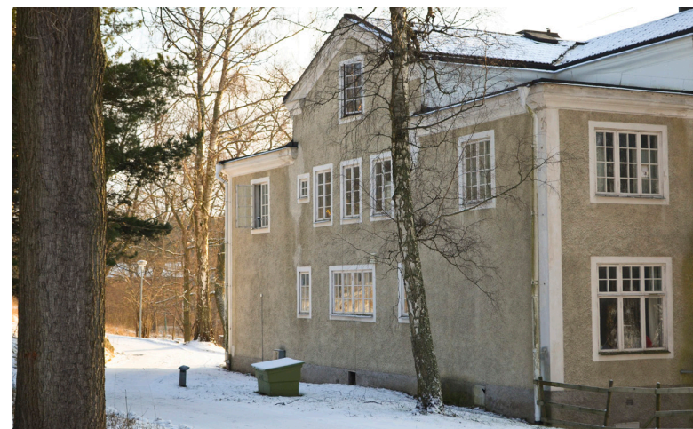
Villans norra fasad vetter mot Gamla Skärgårdsvägen.
