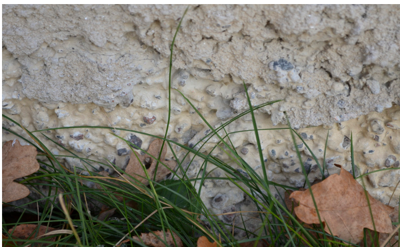
Trolig ursprunglig puts med rundad rödaktig sjösten som ballast sticker fram under den nuvarande.
