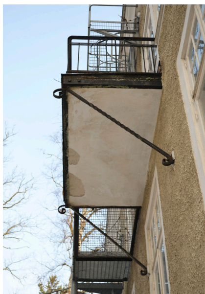
Dekorativa smideskonsoler och räcken på den västra sidans balkong.
