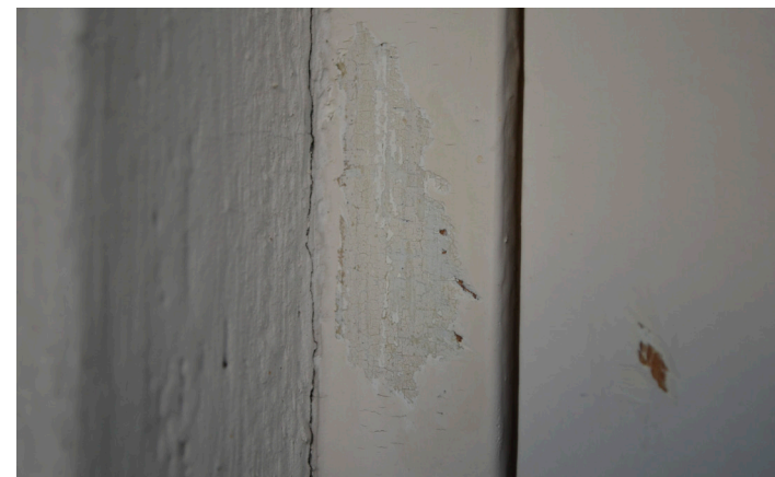
Under dagens snickerifärg finns däremot en något svalare vit kulör målad med oljefärg.
