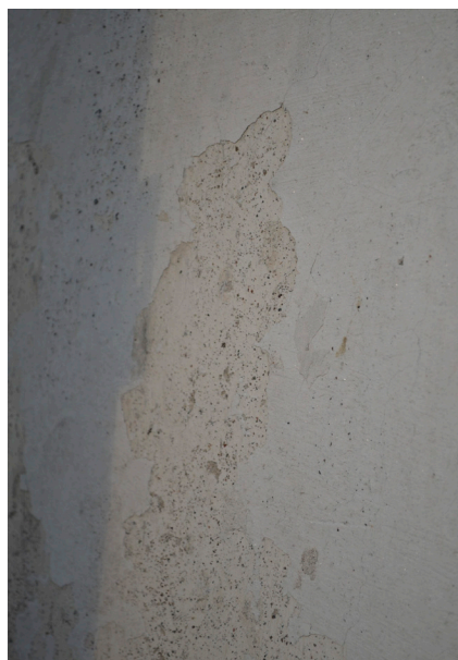
Under dagens kallvita kulör på listverken finns en något varmare vit.
