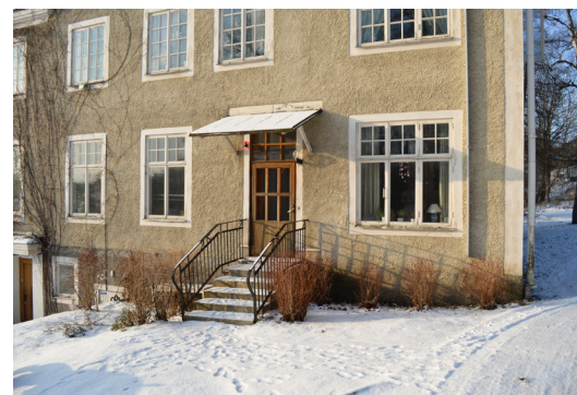
Den norra entrén som tillkommit efter det att orangeriet revs. Här satt ursprungligen en mindre dörr som ledde från husets hall ut till orangeriet.
