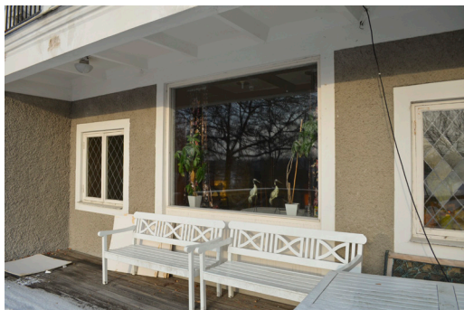
De förändrade fönstren på souterrängvåningen.
