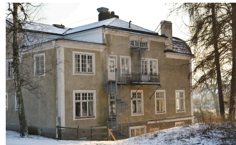
Den västra fasaden med sin sekundära utrymningstrappa.
