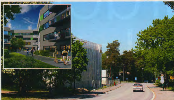
Bygget av huset Åkerlyckan på Skärgårdsvägen i Gustavsberg har återupptagits efter ett halvsårs avbrott. Infälld bild: Illustration färdigbyggt område (Tidigare annons). Bild: IW
