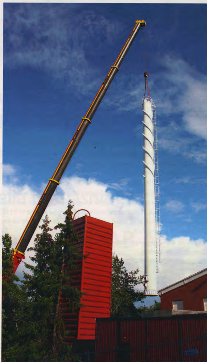
Uppmontering av den 26 meter höga skorstenen på Hemmestahöjden.
