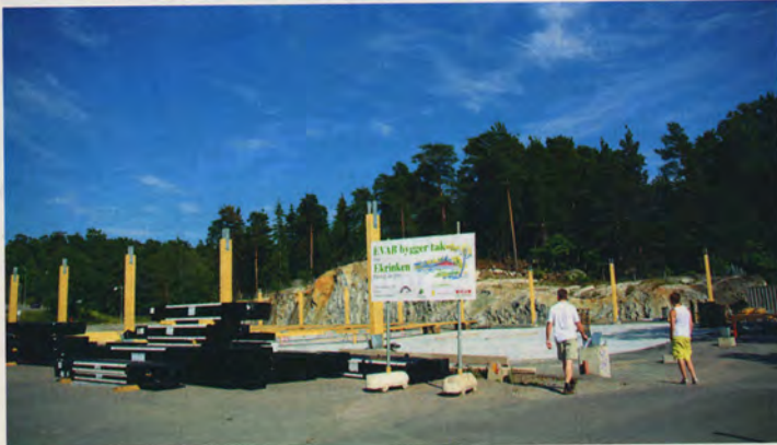
Takbygge över Ekvallens öppna yta pågår och blir klart i höst.
