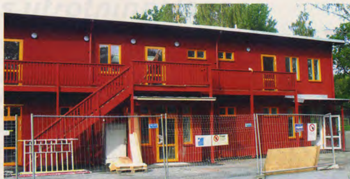
Ingårös församlingsgård invigs Första Advent. Bilden är från bygget i september 2010.
