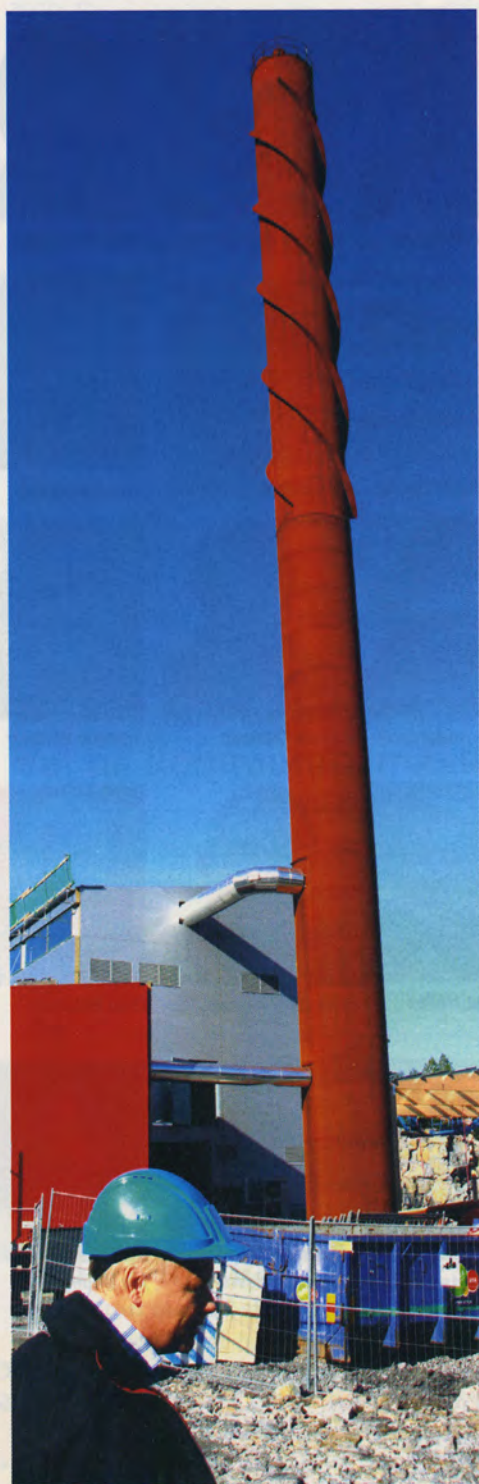
Skorstenen som i huvudsak ska släppa ut vattenånga är 45 meter hög.
