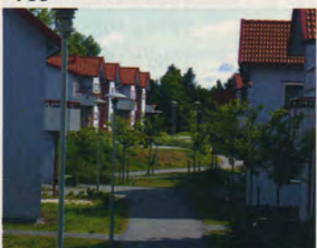
Skänkelvägen, Gustavsberg. Byggår 2005.
