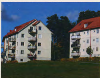
Harry Petterssons väg, Gustavsberg. Byggår 2006.
