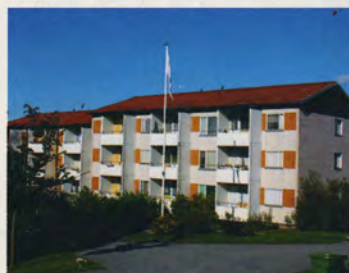
Skyttevägen, Gustavsberg. Byggår 1970.
