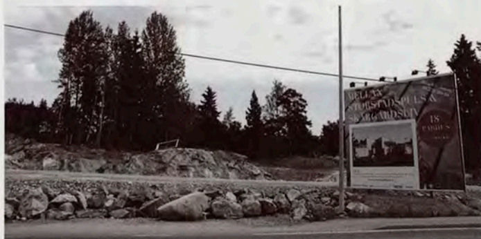
Mörtnäs Hagar strax öster om Värmdö Köpcentrum blir ett nytt bostadsområde.
